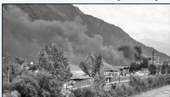
Schwarzer Rauch steigt vom Dach des im Bau stehenden Trakts des Unternehmens Nils AG in Burgstall auf. Foto: J. Bichl
