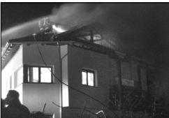
Die Isolierung des Dachstuhls eines Wohnhauses an der Bergmannstraße geriet am Samstagabend in Brand. Der Schaden hält sich in Grenzen.
